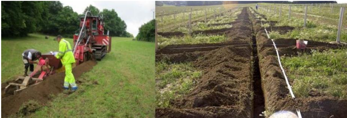
Figure 8. Exemples de travaux d'enfouissement de câbles électriques
