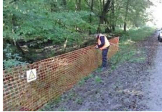
Figure 24. Exemple de clôture de balisage des zones à éviter durant la phase travaux
