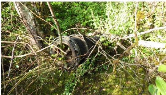
Vue sur l'ancienne arrivée d'eau
