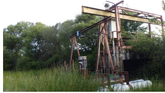
Vue sur l'ancienne station de pompage
