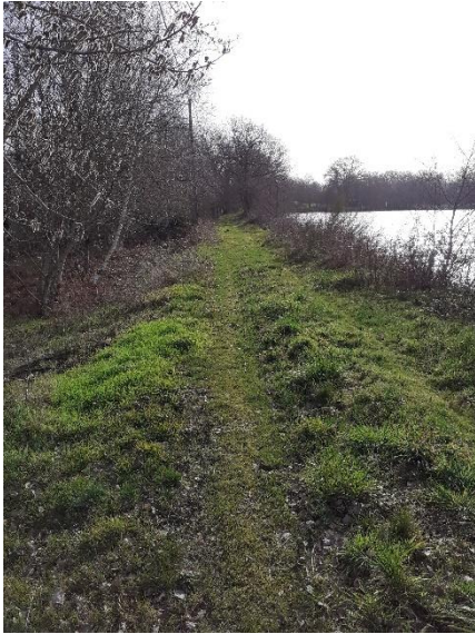
Figure 20. Chemin de la digue nord, zone d'installation de la plateforme temporaire semi-flottante d'assemblage et de mise à l'eau
