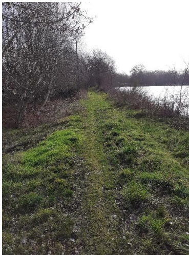
Figure 5. Chemin de la digue nord, zone d'installation de la plateforme temporaire semi-flottante d'assemblage et de mise à l'eau
