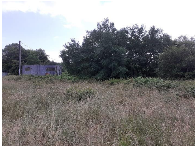
Figure 21. Zone prairiale dédiée à la plateforme temporaire de stockage des panneaux flottants
